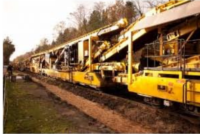
Die weltweit größte Gleisbaumaschine arbeitet zurzeit auf der Heidebahn in Holm-Seppensen © Stadt Buchholz
