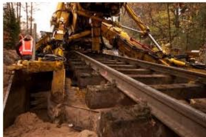
Das Gleisrost wird angehoben, Schotter und Unterbau verschwinden in den so genannten Aushubketten (links) © Stadt Buchholz
