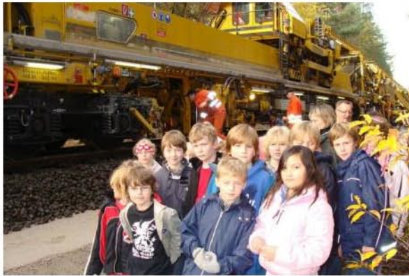
Schulsausflug zur Baustelle. Die Kinder aus der Mühlenschule in Holm-Seppensen sind beeindruckt von den Bauarbeiten an der Heidebahn. Foto: Kanitz-Kabel
