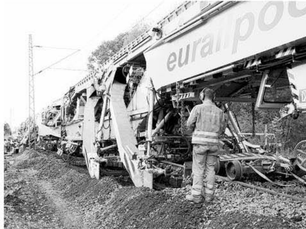
"PM 1000-URM" heißt das 270 Meter lange Ungetüm, das mit mehreren hintereinander arbeitenden Kettenlaufwerken den alten Schotter abträgt und dahinter gleich Sand als neue Untergrundsicht ausbringt. Foto berger
