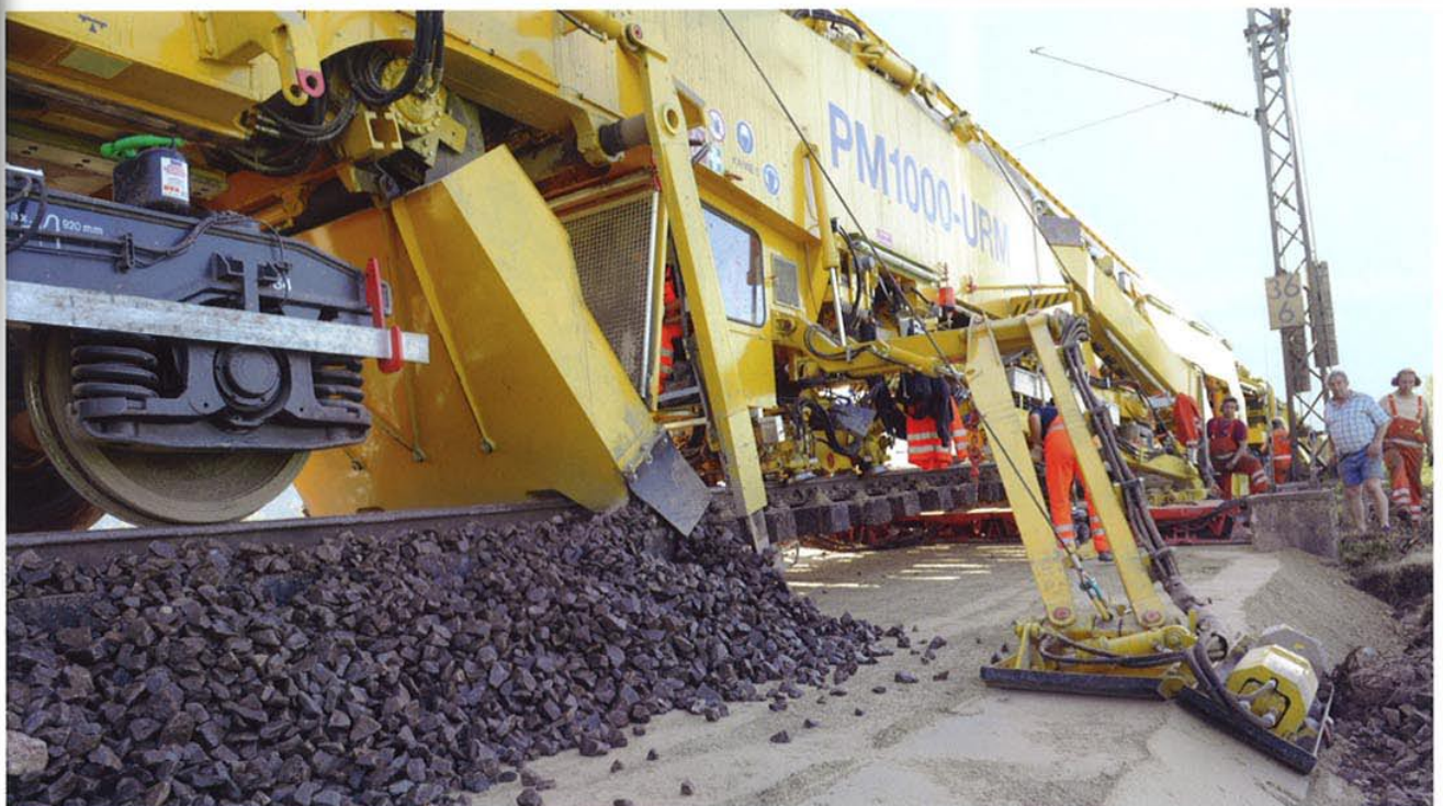
Unterbausanierungsmaschine PM 1000 URM – Verdichtung der Planumsschutzschicht und nachfolgende Schottereinbringung
