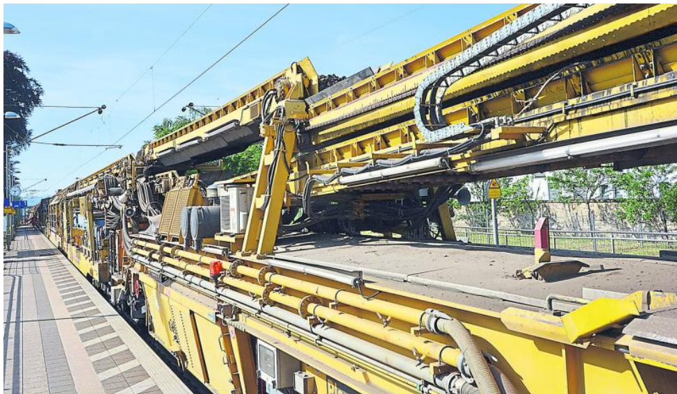
Aufmerksamkeit erregte am Mittwoch der Gleisbauzug PM 1000 URM im Bahnhof Heppenheim.
