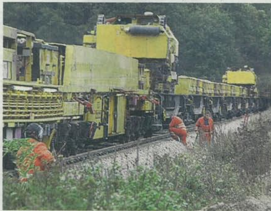
Zwischen Bremervörde und der Brücke Duxbach in Höhe von Deinstedt haben die Arbeiter eines deutsch-österreichischen Unternehmens die Bahnstrecke saniert. Zum Einsatz dabei ist auch der Baumaschinenzug „PM 1000-URM“ gekommen.
