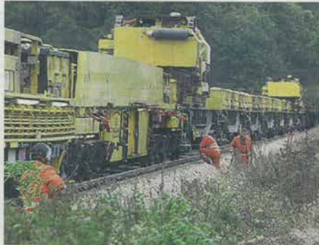
Zwischen Bremervörde und der Brücke Duxbach in Höhe von Deinstedt haben die Arbeiter eines deutsch-österreichischen Unternehmens die Strecke saniert. Zum Einsatz dabei ist auch der Baumaschinenzug „PM 1000-URM“ gekommen.
