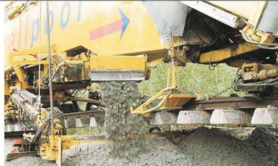
Einbau der Tragschicht mit Herstellung des Planums
