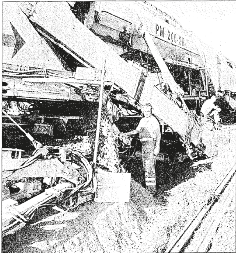
Auf der Hochrhein-Bahnstrecke ist zurzeit die größte, modernste und leistungsfähigste Gleisbaumaschine der Welt im Einsatz. Insgesamt 850 Meter lang ist der gelbe „Tatzelwurm“.
